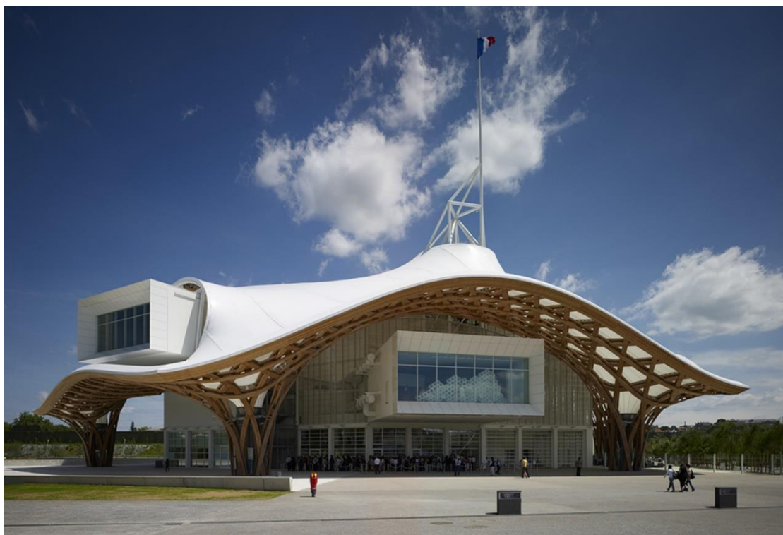
Slika 6 Mrežasta konstrukcija Centar Pompidou, Francuska
