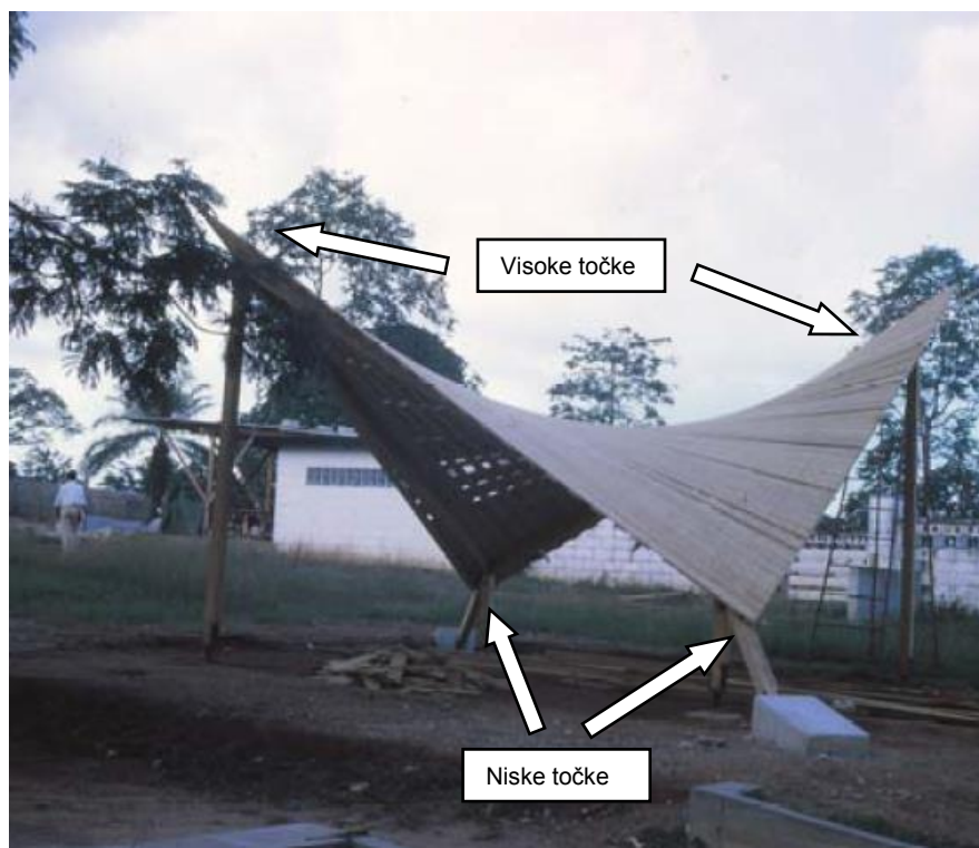
Slika 3 Hiperbolni paraboloid u Gani
