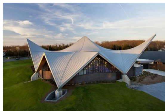
Slika 5 Krovna konstrukcija crkve sv. Alojzija, SAD
